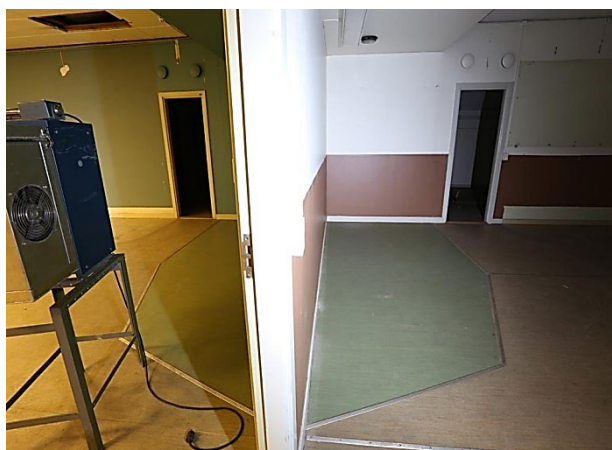
Igensatt golv vid f.d. HC/verkskyddC (med vägg)
