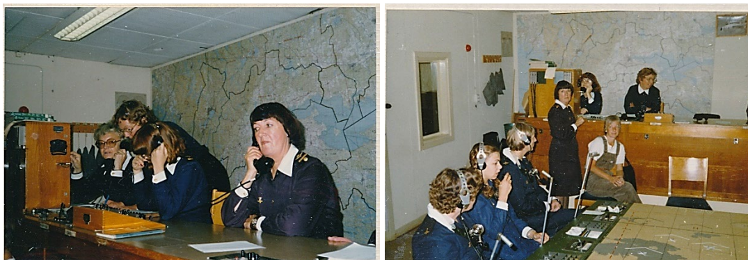
Engagerade Lgc-lottor i arbete i oprummet
